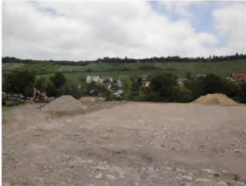
Abbildung 3: Planierte Fläche im Bereich der zukünftigen Lagerhalle
